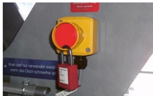
2 Dispositivo di arresto di emergenza in corrispondenza dell'accesso a punti pericolosi.
